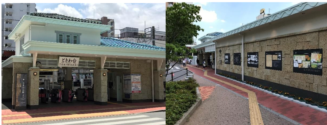
リニューアルした東武東上線ときわ台駅舎 2018年6月 中湖撮影
